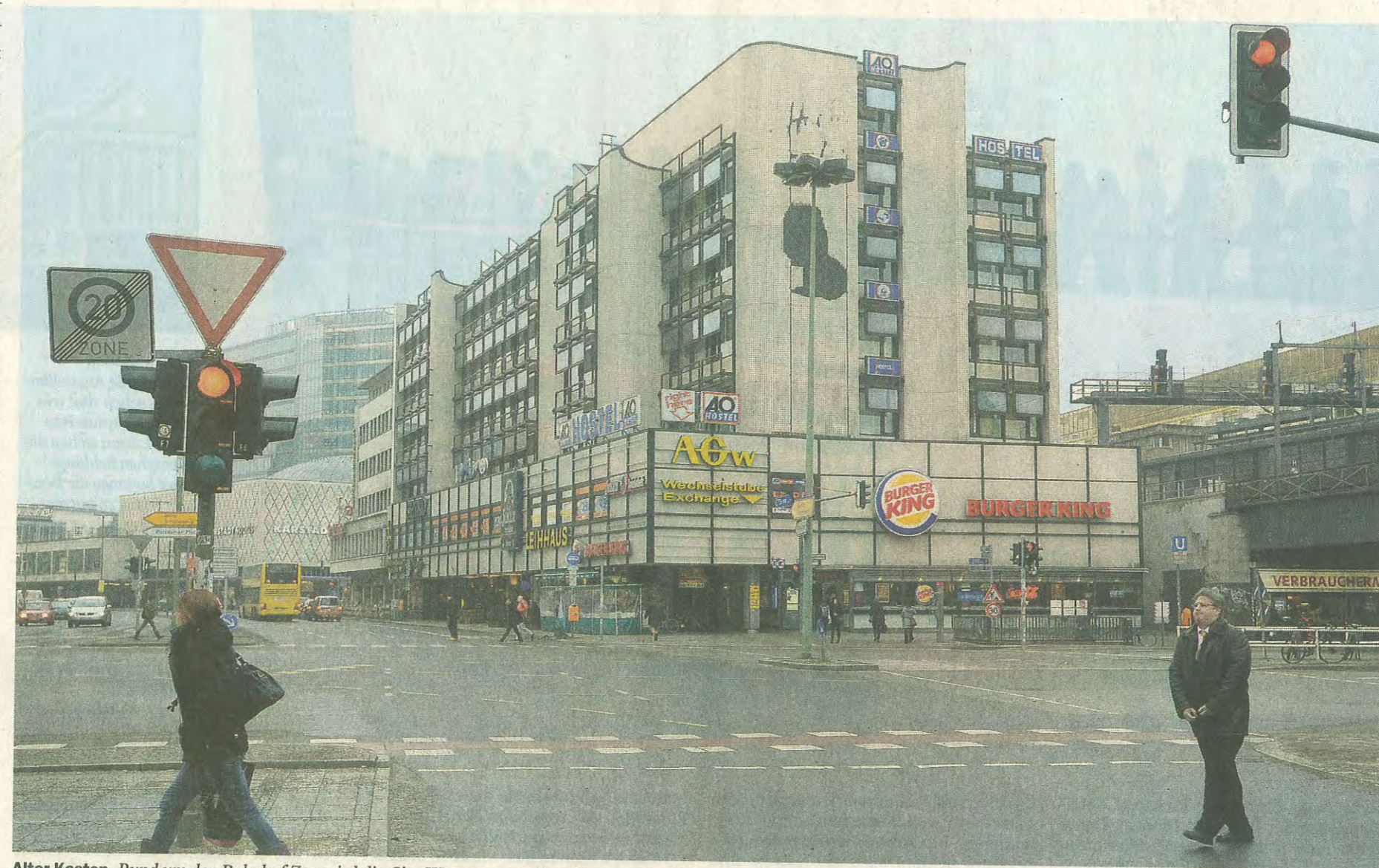
Alter Kasten. Rund um den Bahnhof Zoo wird die City West erneuert. Da fällt umso deutlicher auf, dass am ehemaligen Aschinger-Haus dringend etwas geschehen muss. Foto: Mike Wolff
